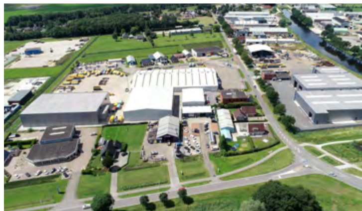
Drie jaar geleden opende Viol in Scheemda een nieuwe bedrijfshal voor archiefopslag
