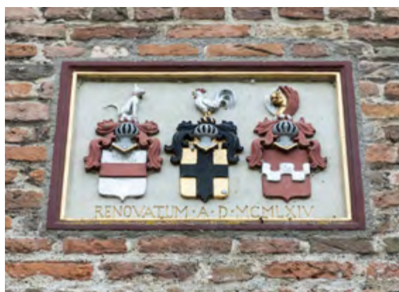
Kasteel Doornenburg is een van de best bewaarde kastelen van Nederland. Deze gevelstenen herinneren aan de laatste restauratie in 1964
